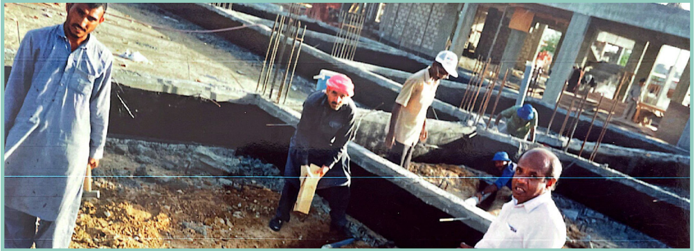
مرحلة البناء لمدارس الذكر
